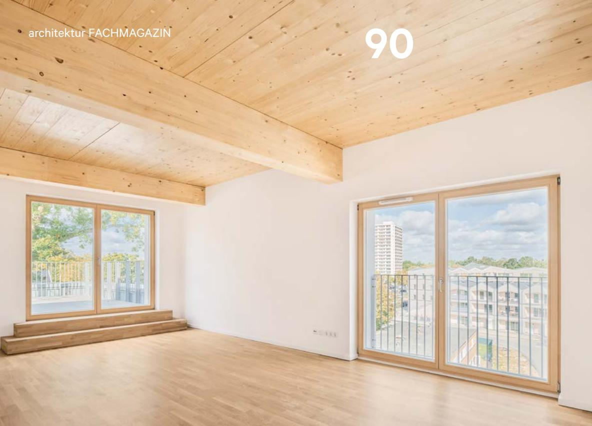
**Auch die Brettsperrholzdecken bleiben weitgehend unverkleidet. Aus brandschutztechnischer Sicht besonders interessant: In Skelle ist – bis auf die Sichtbetontreppe – sogar der Erschließungskern in Massivholz ausgeführt.**
