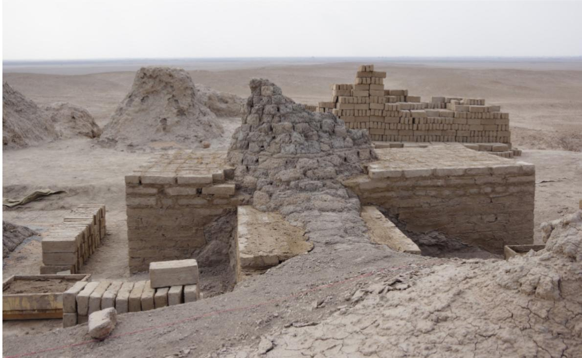
Titel: 3 Phasen der Notsicherung | Ummanteln des Originalbefunds gemäß detektierter Reste am Mauerwerksfuß (vorne) | Freilegen des soliden Kerns (Mitte) | Bodenkonsolidierung (rechts hinten) | Anarbeiten an Reste des Originalmauerwerks aus Lehmstein
