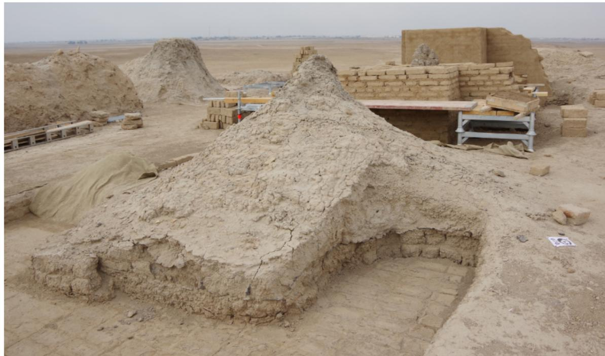
Fertigstellung der Bodenkonsolidierung (links) | Ergänzung des Mauerwerks (Mitte) |
