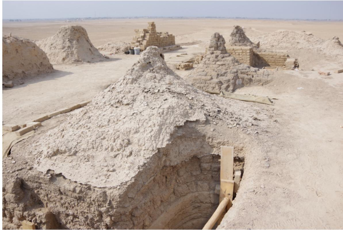
Phasen der Umsetzung (v. l.): Bodenkonsolidierung (links) | Putzen der erodierten Schichten (Mitte) | notsichernde Ergänzung des Mauerwerks aus Lehmsteinen und Lehmmauermörtel entsprechend der Eigenschaften des Originals (hinten)
