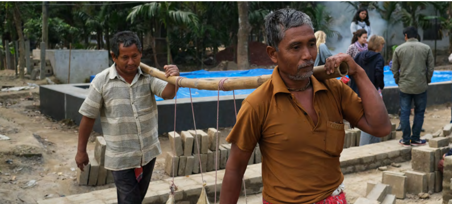
Die Bauarbeiter beim Transportieren der Materialien – Foto: Björn Weber
