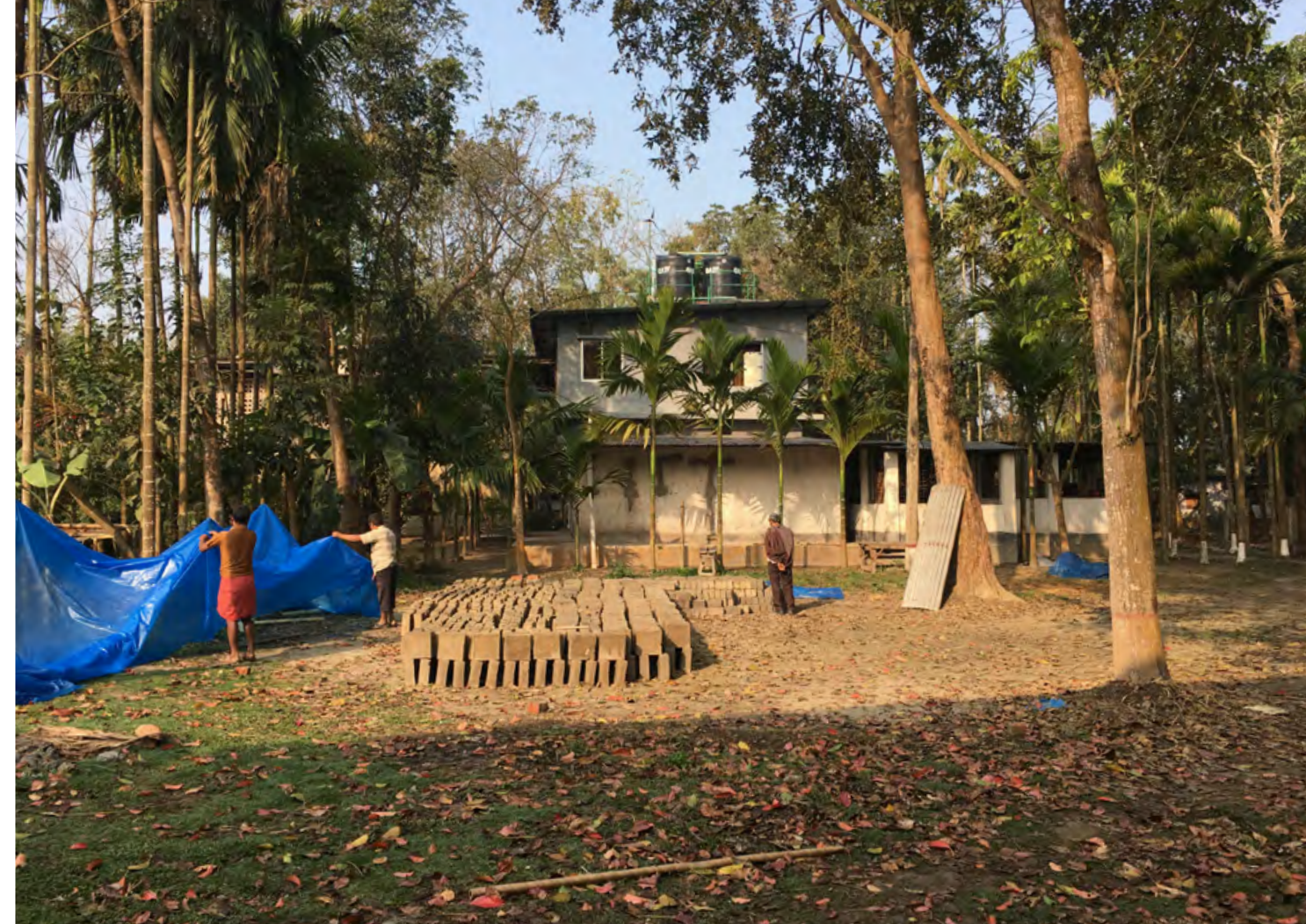
Bereits fertig gestellte Bausteine – Foto: Björn Weber
